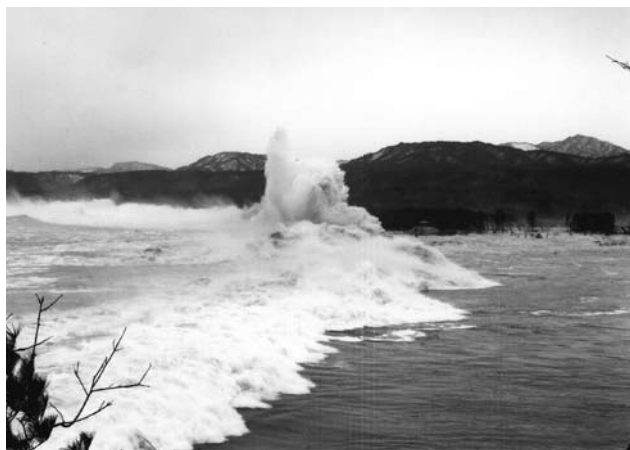
津波の第二波で堤防が壊れ、巨大な水柱が上がる。 その向こうが防潮林
