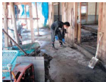
雫石町災害VC/屋内外の泥撤去作業 (8月25日)
